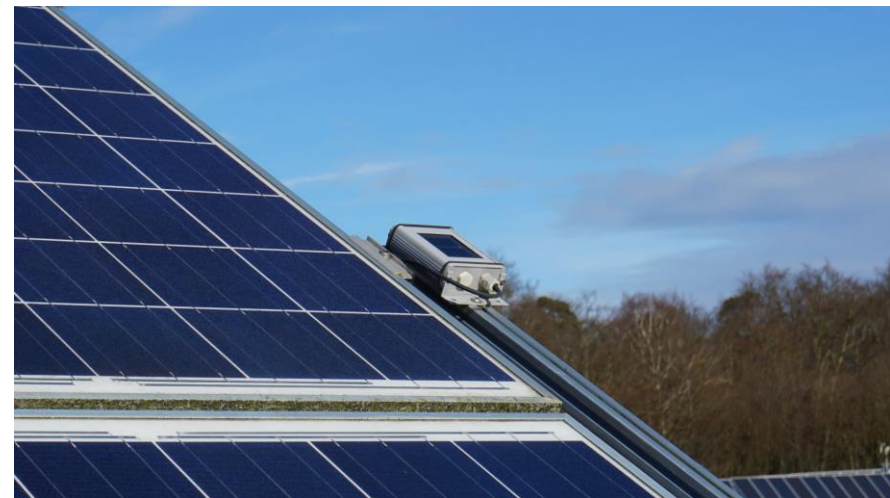
Bild 60 Die Prüfstände der PV-Speichersysteme, die Online-Wetterprognosen in ihr Energiemanagement einbinden, bezogen in einem Intervall von 1 s die aktuellen Strahlungsmesswerte eines kristallinen Siliziumsensors (Bild: KIT).
